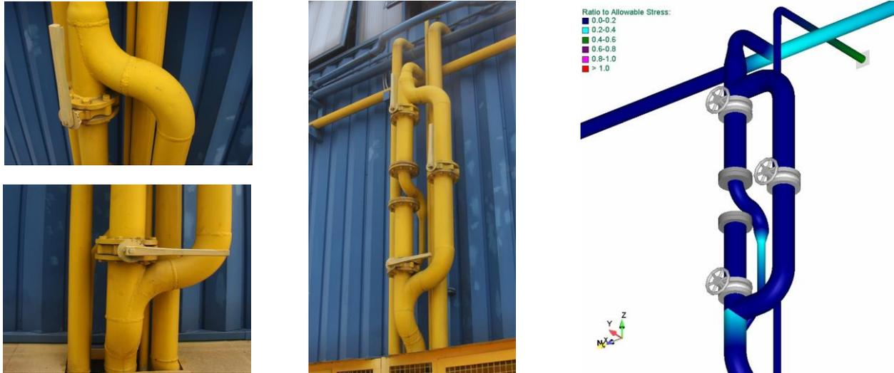
Figura 8 – Case study: tubazione reale dotata di due elbow-tee e stress analysis con modellazione tramite branch-connection standard e  $SIF_e$  calcolati tramite l'Eq. (4).
